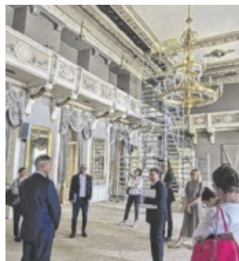
Der historische Redoutensaal wird behutsam restauriert.
