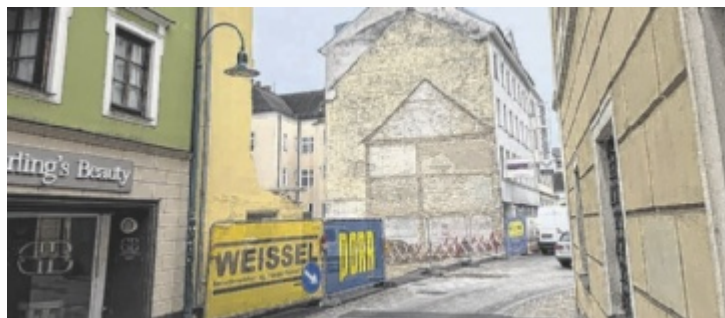
Am Ende der Herrenstraße klafft derzeit eine große Baulücke.
