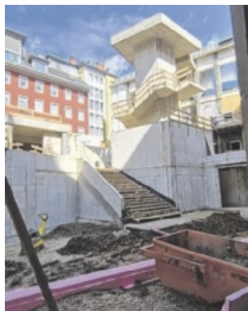
Ein Blick in den neuen Innenhof, der die Studiobühne mit der Lessingstraße verbindet.
