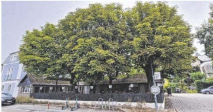
Besonderes Augenmerk wird beim Umbau des Schwarzen Schiffs auf den Erhalt des Gastgartens mit seinem Kastanienbaumbestand gelegt. Fotos: Tips/Heindl (2)
