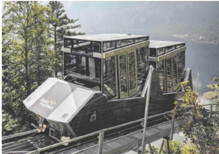
Neue Standseilbahn in den Salzwelten Hallstatt
