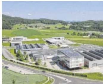
Der Baustart am Betriebsbaugelände soll heuer erfolgen. Fotos: Gemeinde Neumarkt
