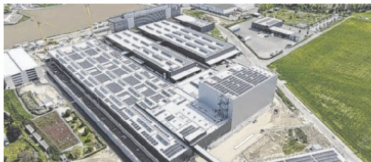
Blick auf das TGW-Hauptquartier in Marchtrenk
