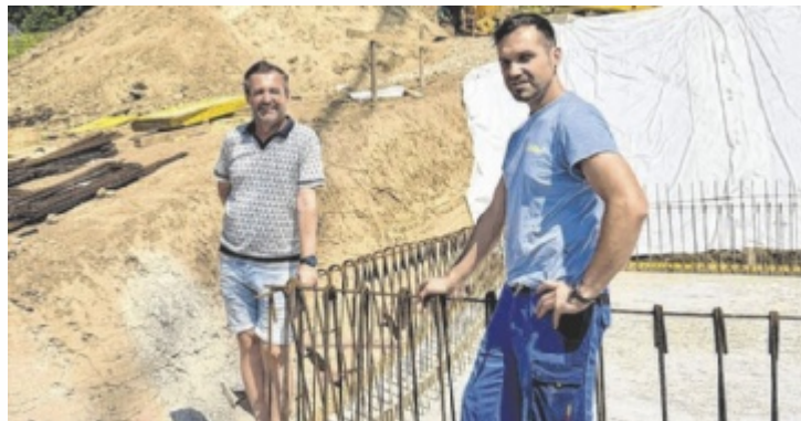
Bgm. Jürgen Lachinger (l.) und Christian Rieger, Obmann des Wasserverbandes Gampern, bei einer Baustellenbegehung in Bierbaum. Foto: Gemeinde Gampern/Kühn
