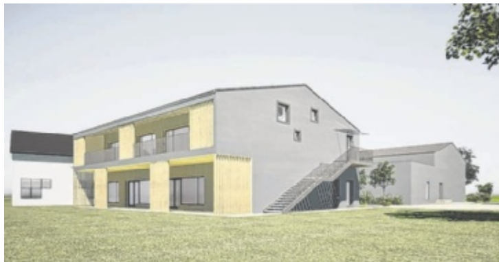
Der Kindergarten in Ternberg wird ausgebaut und modernisiert. Foto: Gemeinde Ternberg
