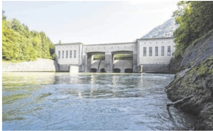
Das Kraftwerk in Großraming
