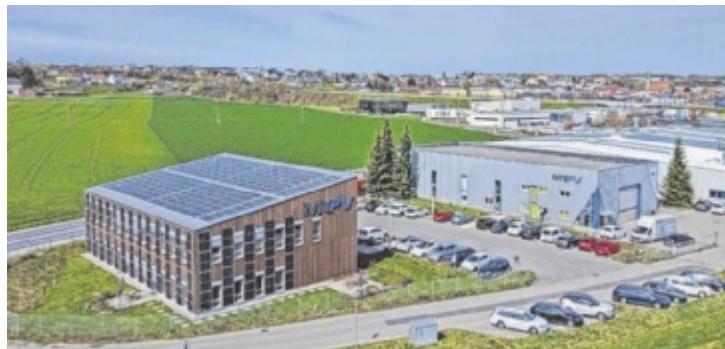
Rund eine Million Euro investiert my-PV in den Ausbau.
