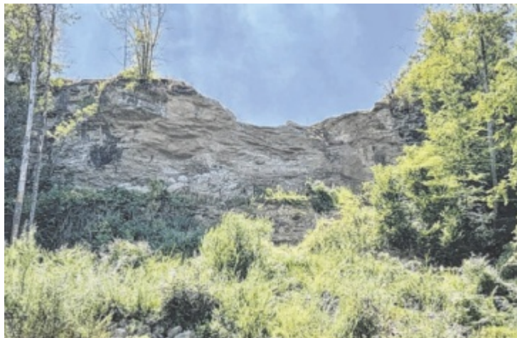
An dieser Felswand werden die Arbeiten durchgeführt.
