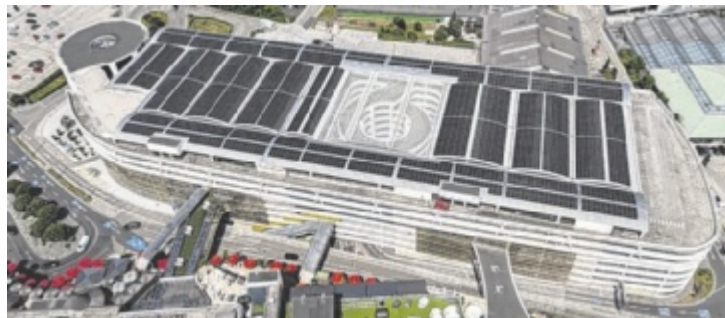
Die neue Photovoltaikanlage auf dem Parkdeck B
