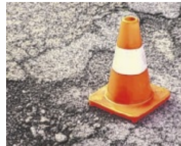
Bauarbeiten Foto: studio v-zwoelf/adobe.stock
