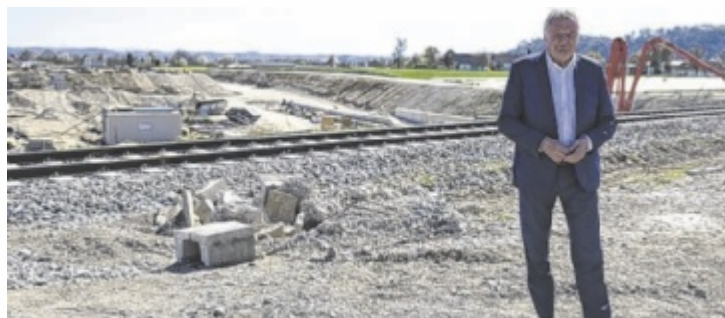
Landesrat Steinkellner bei der Baustelle
