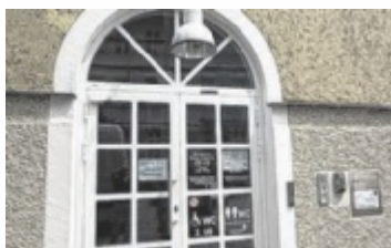
Öffnungsschalter installiert Foto: Madl
