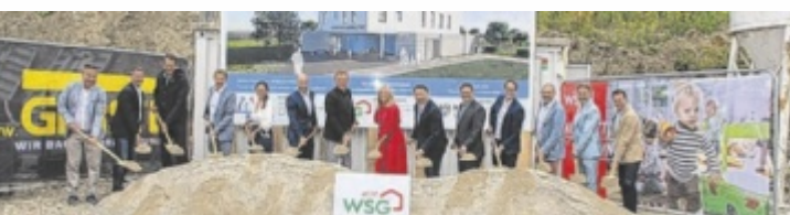
Der Startschuss für das neue Kinderhaus ist mit dem Spatenstich gefallen. Foto: WSG
