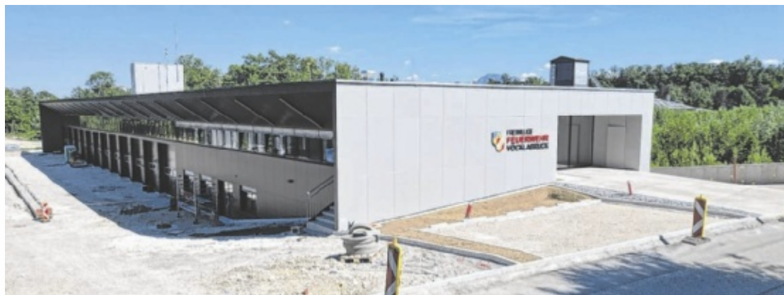
Nach der kurzen Sommerpause werden die Arbeiten mit den Asphaltierungsarbeiten im Außenbereich fortgesetzt.
