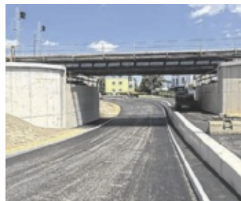
Die Gesamtfertigstellung der Unterführung beim Bahnhof ist im Sommer 2027 geplant. Foto: Wesp-Baumgartner_ÖBB
