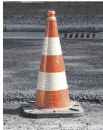
Im Gemeindegebiet von Schwertberg laufen Straßensanierungsarbeiten des Landes OÖ. Symbolfoto: flashpics/stock.adobe.com
