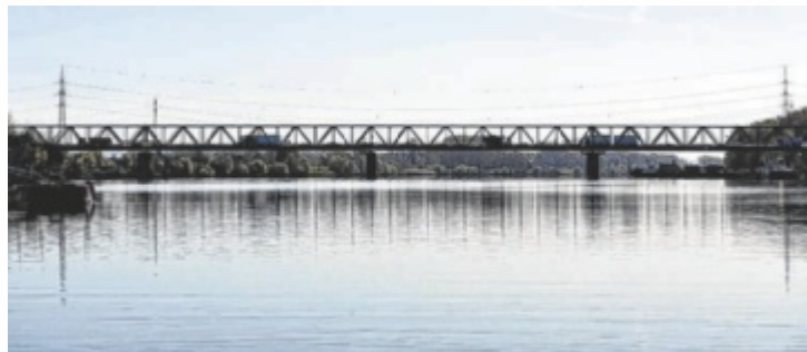
Die bestehende Donaubrücke Mauthausen.
