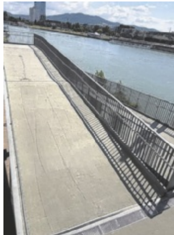
Die neue Rampe beim AEC ist für den Verkehr freigegeben. Foto: Tips/Nagy
