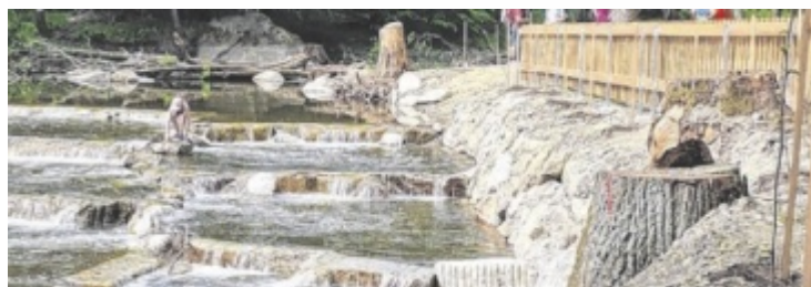
Die neue Fischaufstiegshilfe in der Kriehmühle
