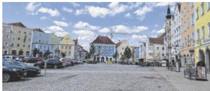
Kräne sichern das Haus am Unteren Stadtplatz in Schärding.
