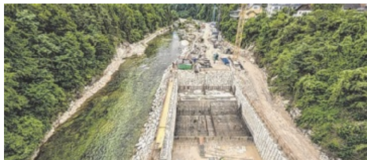
Neubau des Kraftwerks Traunfall
