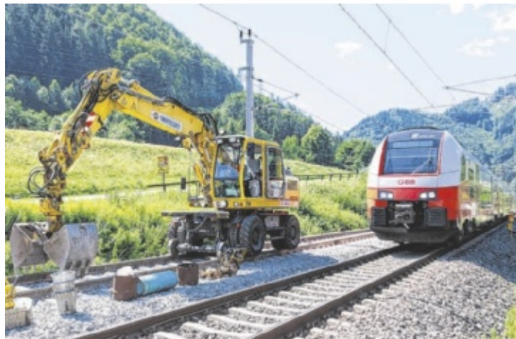
Entlang der Ennstalstrecke kommt es im Sommer zu Bauarbeiten.
