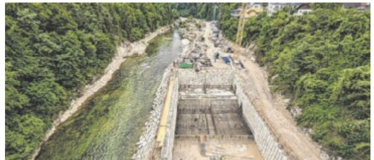
Neubau des Kraftwerks Traunfall
