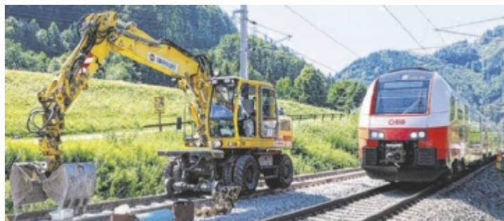
ÖBB saniert im Sommer einige Strecken und Infrastrukturen
