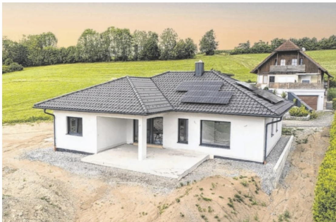
Der FIXPREISHAUS Bungalow von DREIHANS wurde in Ziegel-Massivbauweise errichtet.
