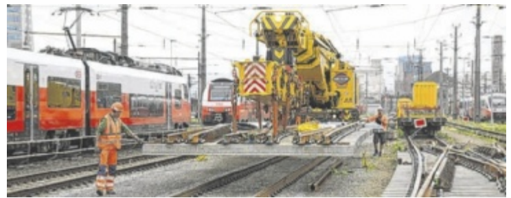
In den Sommermonaten sind Baumaßnahmen geplant.
