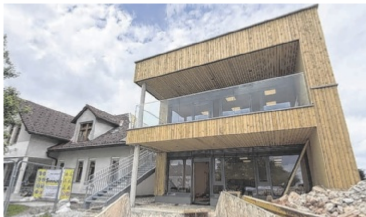
Die Baustelle beim Kindergarten Oberneukirchen
