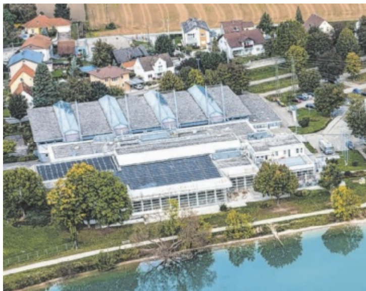
Das Trauner Hallenbad, dessen Schließung bis spätestens Sommer 2027 geplant ist, sorgt bei lokalen Sportvereinen für Besorgnis und Kritik. Foto: Christian Redtenbacher
