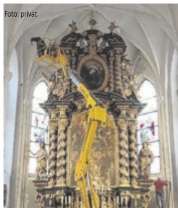
Mit einer Teleskopmastbühne wurden auch die höchsten Stellen erreicht.
