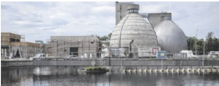
Vorne ein Nachklärbecken, dahinter das Betriebsgebäude, die erweiterte Maschinenhalle und die Faultürme
