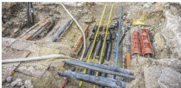
Arbeiten am Kaiser-Josef-Platz
