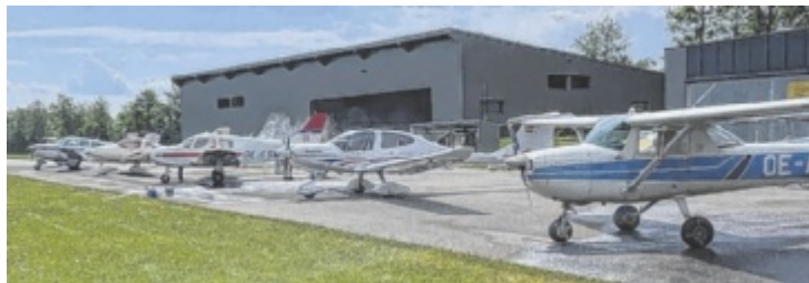
Der Flugplatz wurde mehrfach ausgebaut und modernisiert.
