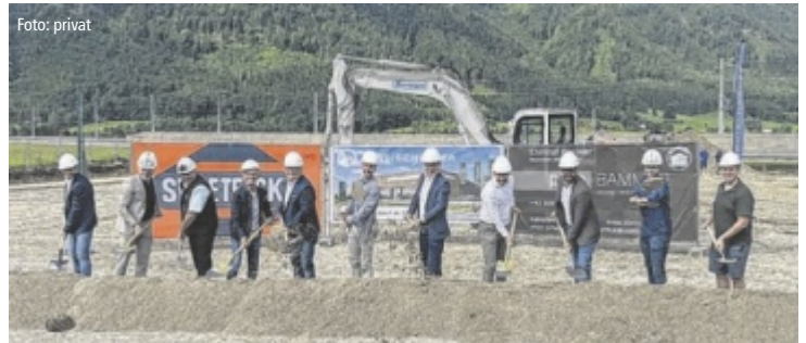
Vertreter von Gemeinde, Baufirma und Autohausfiliale beim Spatenstich in Micheldorf
