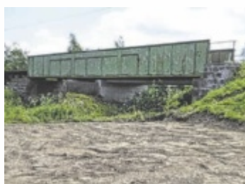
Baustelle der Lokalbahn an der Bahnbrücke in der Ortschaft Parzham, Gemeinde Waizenkirchen
