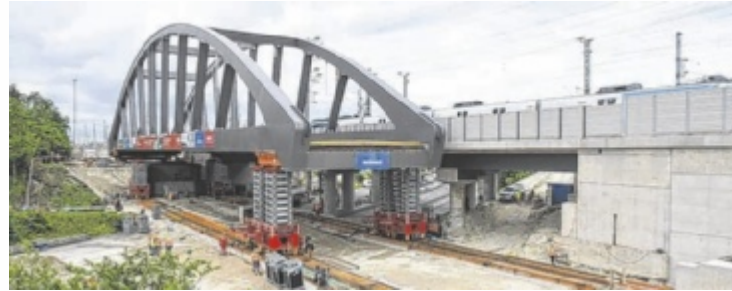
Ein hydraulisches Fluid-System mit Stickstoffunterstützung reduzierte die Reibung erheblich und ermöglichte das kontrollierte Verschieben. Foto: ÖBB/Deopito
