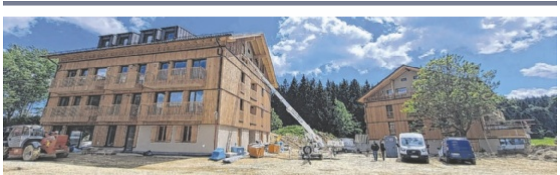
Vier Häuser mit 77 Apartments entstehen in Seitelschlag. Nachhaltigkeit und Regionalität spielen hier eine große Rolle.
