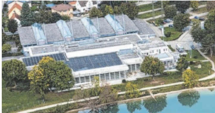
Das Badezentrum am Oedtersee ist nach dem aktuellen statischen Gutachten nur noch eingeschränkt und befristet nutzbar.
