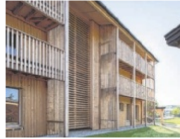
Holzbau ist die Zukunft!
