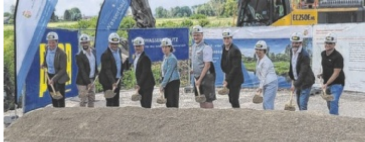
In Helpfau-Uttendorf fiel der offizielle Startschuss für den Bau des lang ersehnten Hochwasserschutzes. Foto: Tips/Kastenauser
