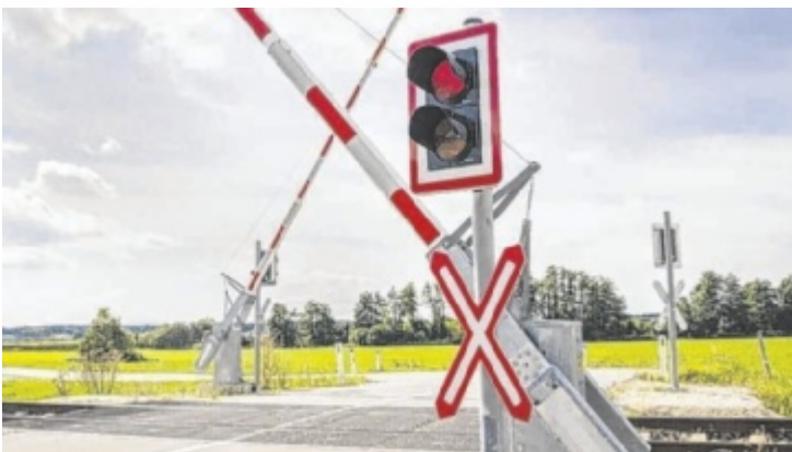
Die finalen Elektrifizierungsarbeiten erfordern eine Streckensperre. Foto: ÖBB, Pleschko
