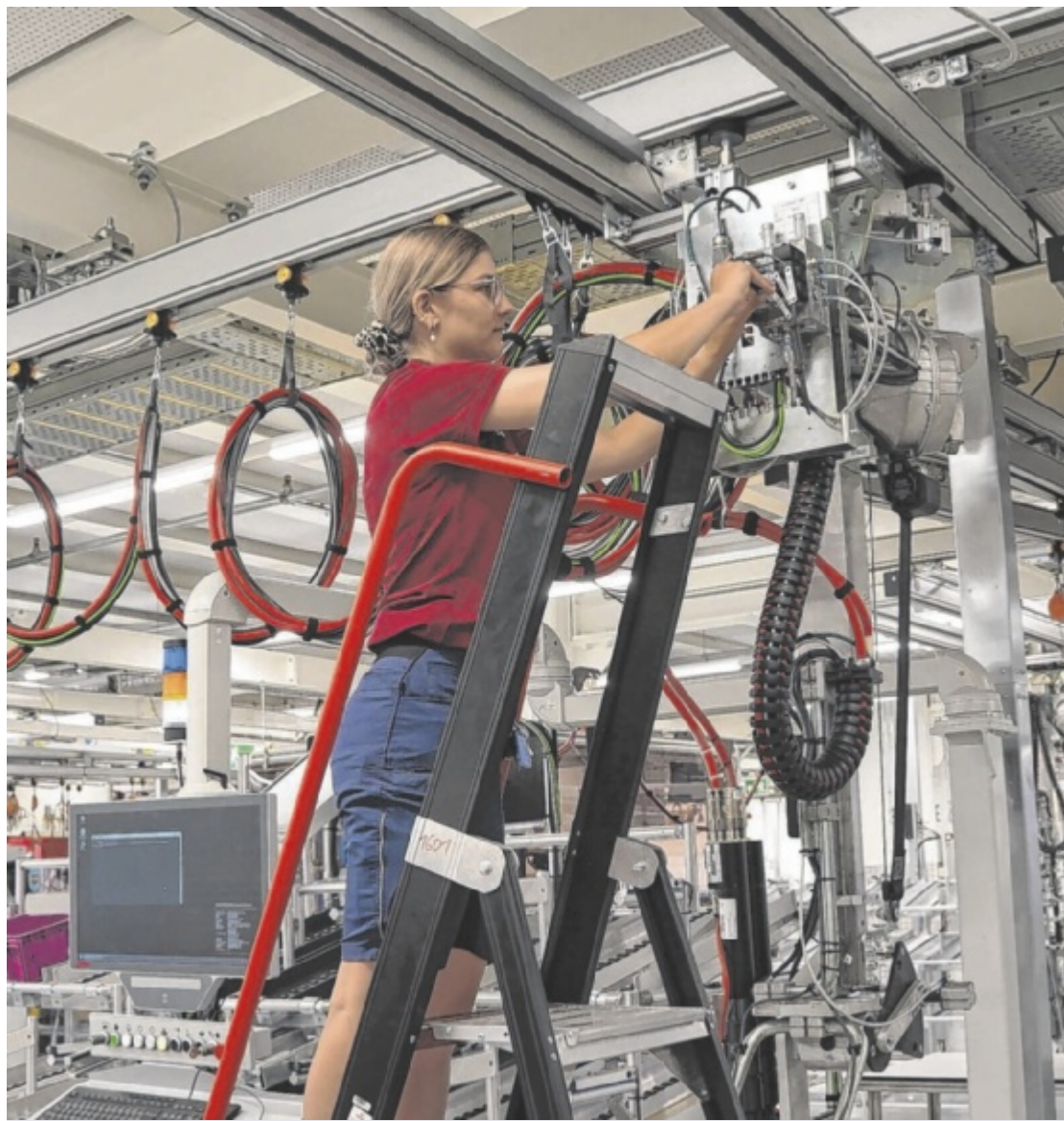
Umbau bei BMW 2027 startet die Vorserie für Wasserstoff-Antriebe im BMW Werk in Steyr. Schon jetzt laufen die Umbauarbeiten in der ehemaligen V8-Produktion. Rund 50 Millionen Euro werden investiert. Seite 7 / Foto: BMW Group Werk Steyr
