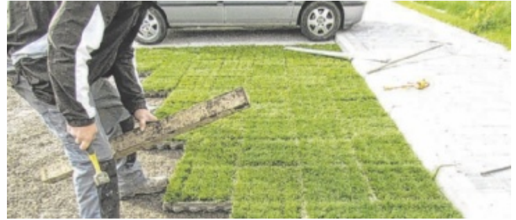
Die Rasengitter sind vorbegrünt.
