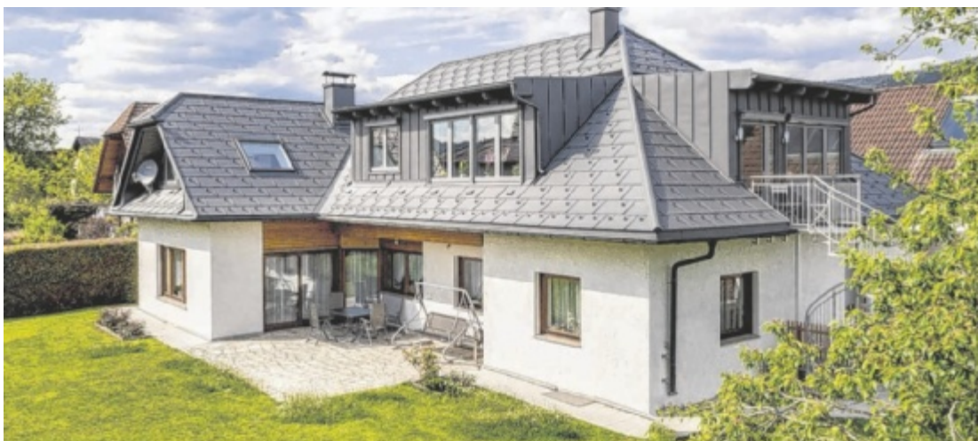
Durch den Dachbodenausbau entsteht neuer Wohnraum im bestehenden Haus.
