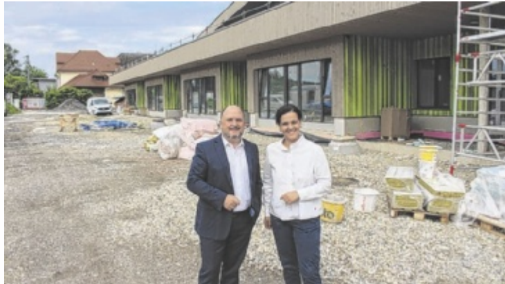
Bürgermeister Bernd Schützeneder und LABg. Helena Kirchmayr auf der Baustelle des neuen Kinderhauses in St. Florian
