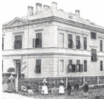
Altes Stiftungshaus (errichtet 1889)
