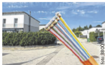
Glasfaser-Ausbau im Bezirk Wels Land
