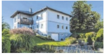
Bestehendes sinnvoll erweitern statt teuer neu bauen Foto: WOLF Haus
