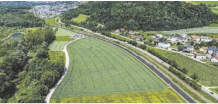
Die B3 ist wieder für den Verkehr freigegeben.
