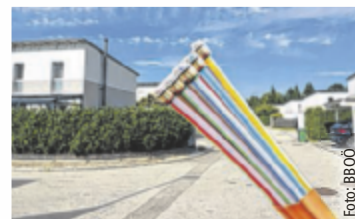
Glasfaser-Ausbau im Bezirk Rohrbach
