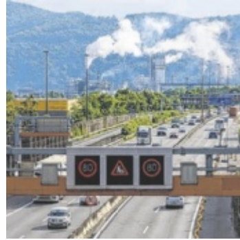
A7 Mühlkreisautobahn Foto: ASFINAG
