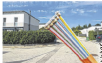
Glasfaser-Ausbau im Bezirk Schärдинг
