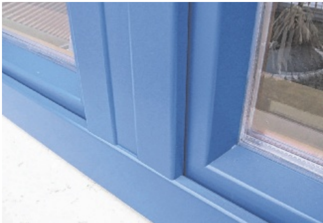
Saniertes Fenster mit Aluminiumverkleidung
