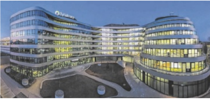
Der Dynatrace Campus in Linz
