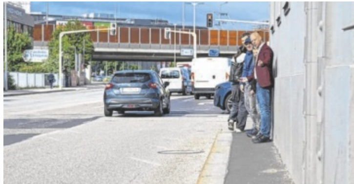
Von 90 Zentimeter auf drei Meter wird der Gehsteig ausgebaut.
